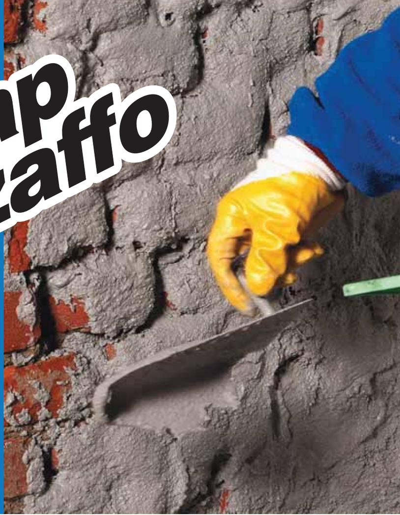
Готовая к применению сухая смесь, стойкая к воздействию солей, служит подслоем перед нанесением осушающих и теплоизолирующих штукатурок **PoroMap Intonaco**
